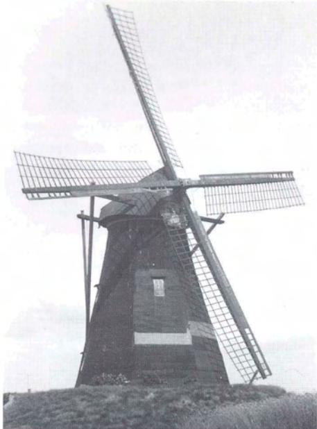
De molen van Vinkel, enkele weken voor de verplaatsing naar Holland-Michigan in 1964. De molen is gedekt met houten beschot, waar teerpapier op aangebracht is. (Foto: N. Jurgens)
